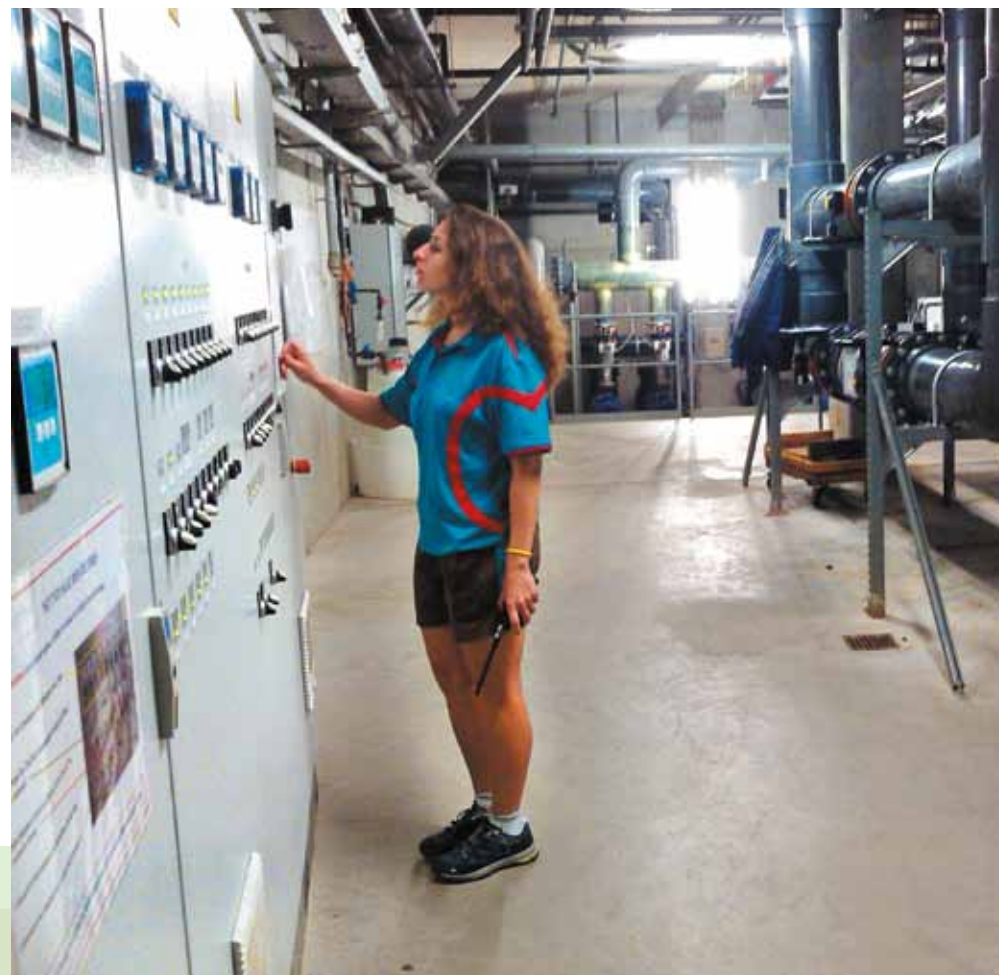
Contrôle technique des installations de l'Aquamundo
