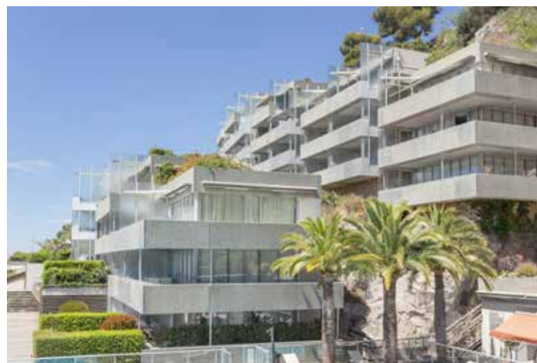
Résidence Pierre & Vacances Costa Plana, signée Jean Nouvel, implantée sur les hauteurs de Cap d'Ail
